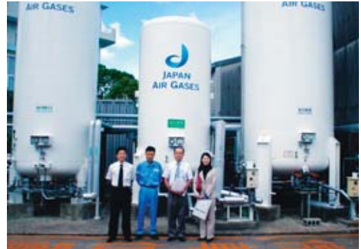
工業ガス管理状況の現地調査
