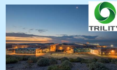
豪州アデレードの海水淡水化プラント
