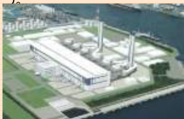
東京電力の川崎火力発電所
