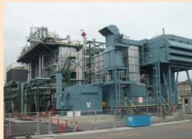
三重県四日市市のガスタービン発電所
