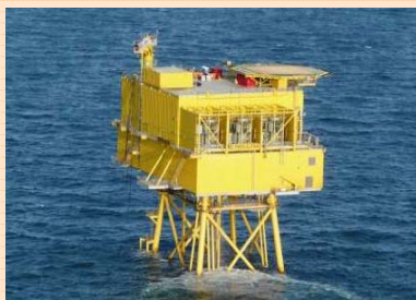
英国海底送電事業の洋上変電所
