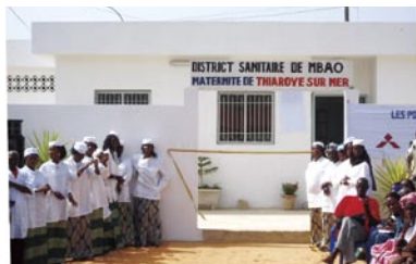
セネガルで建設を進めている産科病院
