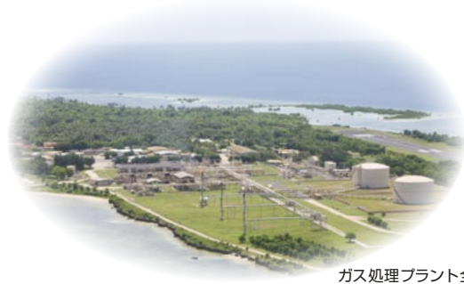
ガス処理プラント全景 (パゲルガン島)
