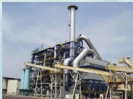
三菱商事と中国木材が出資する「神之池バイオエネルギー」は2008年7月に事業をスタート。燃料を樹皮などのバイオマスのみで賄っていることが特徴で、木質系バイオマス専焼発電所としては国内最大級の出力(21,000キロワット)を誇る
