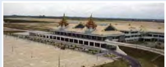
マンダレー国際空港 (写真提供: ミャンマー政府航空局)
