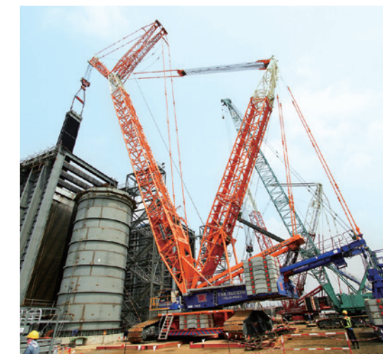
移動式クレーン
