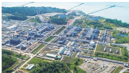
既存液化設備2系列および建設工事の拡張系列、LNGタンク、棧橋等
