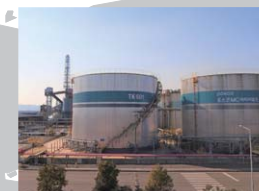
Fabricación y Venta de Coque de Aguja (Corea del Sur)
