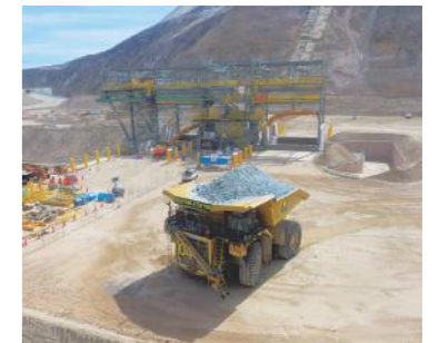
Quellaveco Copper Mine Project (Peru)
