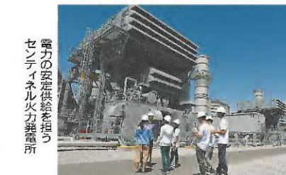
セテイル火力発電所
