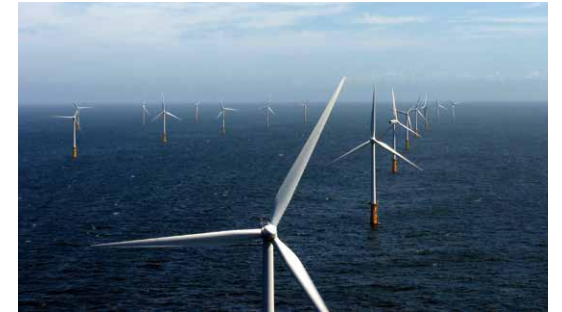
欧州・次世代エネルギー本部 (Eneco)
