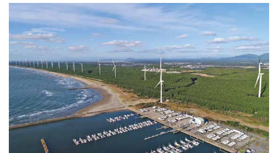
国内電力室 (三菱商事エナジーソリューションズ)
