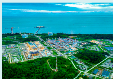
タンブー LNG プロジェクト
