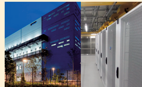
印西市のDC外観とデータホールのイメージ (提供：MCデジタル・リアルティ(株))
