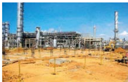
METANOL DE ORIENTE, METORの設備増強 同社では、生産能力75万トン/年の既存工場の隣接地で85万トン/年の増設プロジェクトが進行しています。2010年の第1四半期より商業運転開始予定です。
