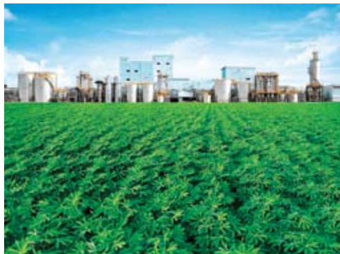
MC-TOWA International Sweetenersの タイのマルチトール生産工場
