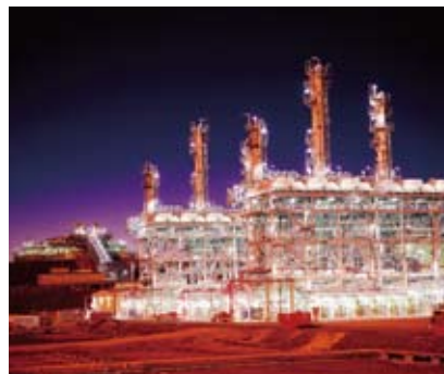
生産されたガスからLNGを生産する液化設備
