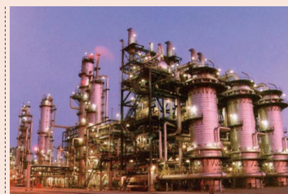
SHARQの増設工事完成後の年間生産能力は、エチレン250万トン、ポリエチレン160万トン、エチレングリコール150万トンと、従来のほぼ倍となり、単一工場としては世界最大の規模となります。
