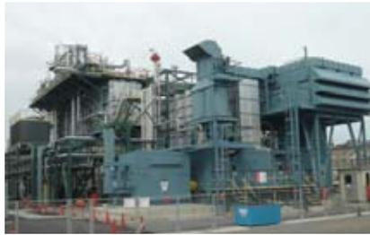
地球環境に配慮した天然ガス焚き最新鋭ガスタービン発電設備。(MCJエネルギーサービス(当社100%子会社)オンサイト発電設備)。
