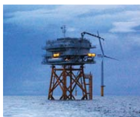
洋上変電所（イギリス）
