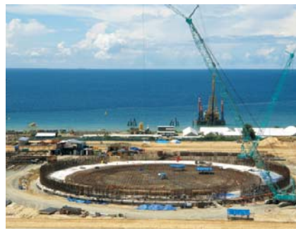
ドンギ・スノロLNGプロジェクトでは2014年末の生産開始を目指しプラント建設工事が進行中です。
