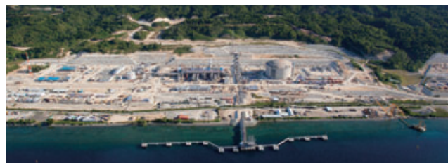
建設中のドンギ・スノロLNGプロジェクト
