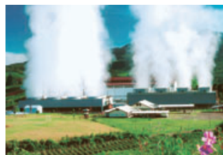
三菱商事が参画するインドネシアの地熱発電会社が運営するWayang Windu地熱発電所。
