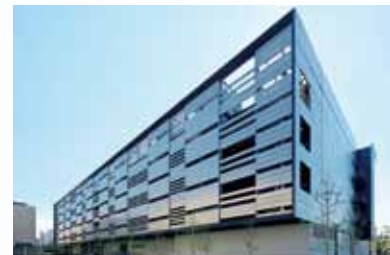
東京・三鷹に新設したデータセンター
