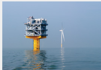
英国西海岸沖の洋上変電所
