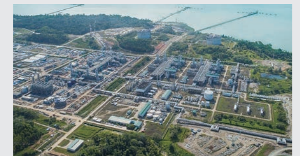
液化プラント既存第2系列および建設工事の拡張系列、LNGタンク、棧橋等
