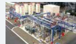
川崎脱水素プラント
