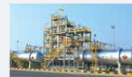
ブルネイ水素化プラント
