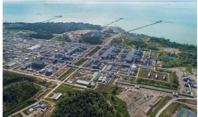
液化プラント既存第2系列および建設工事中の第3系列、LNGタンク、栈橋等
