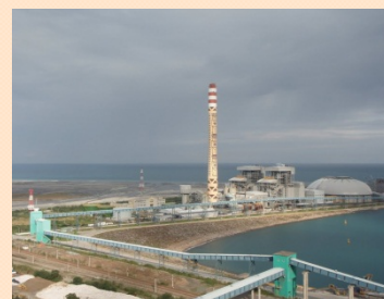
台湾の石炭火力発電所に出資
