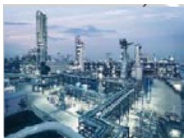
SHARQ（サウジアラビア） 世界最大級の石油化学プラント
