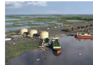
キャメロンLNG (米国) 米国大型LNG輸出プロジェクト
