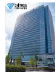
千代田化工建設 (日本) 総合エンジニアリング企業 (世界のLNG生産設備の 約40%に建設関与)
