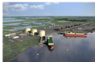
キャメロンLNG（米国） 米国大型LNG輸出プロジェクト
