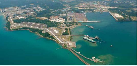
マレーシアLNGプロジェクト
