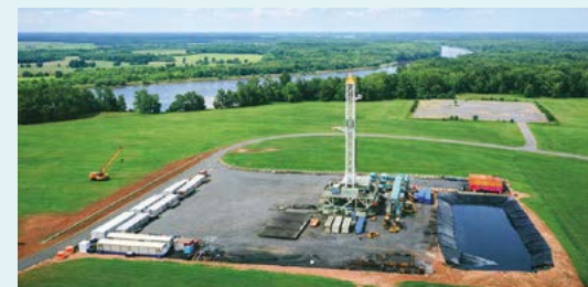
当社が参画するシェールガス事業の掘削開発現場
