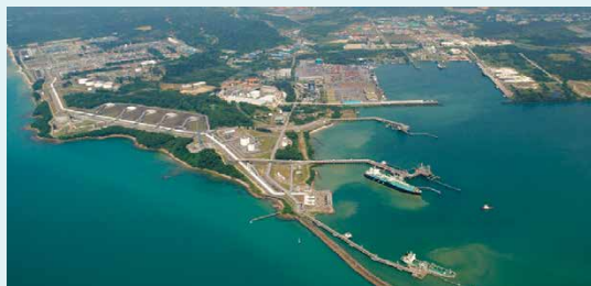
マレーシアLNGプロジェクト
