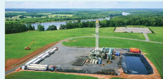
当社が参画するシェールガス事業の掘削開発現場
