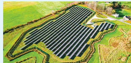
Nexamp社の分散型太陽光発電設備
