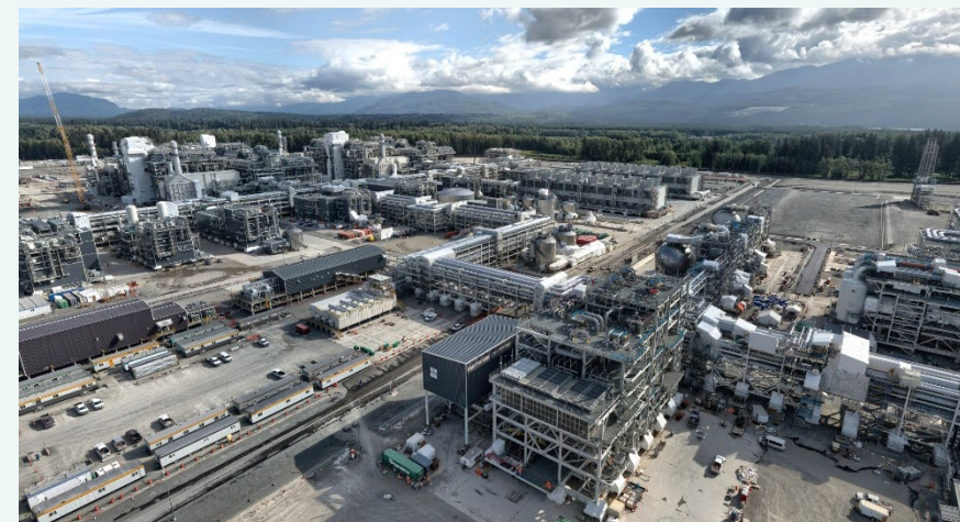
LNGカナダプロジェクト 建設状況（本年8月時点）
